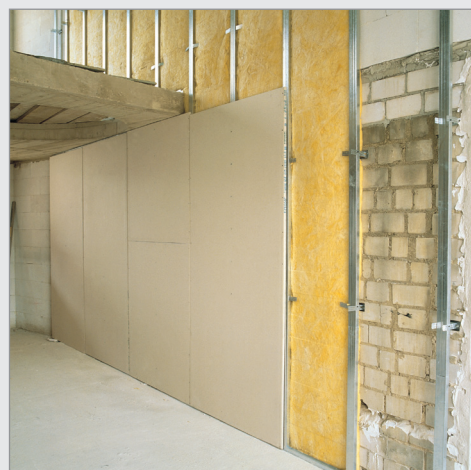
عایق‌کاری حرارتی و صوتی دیوارهای خارجی ساختمان
