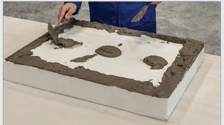
نشاندن چانه‌های چسب سیمانی مخصوص بر روی قطعات عایق
