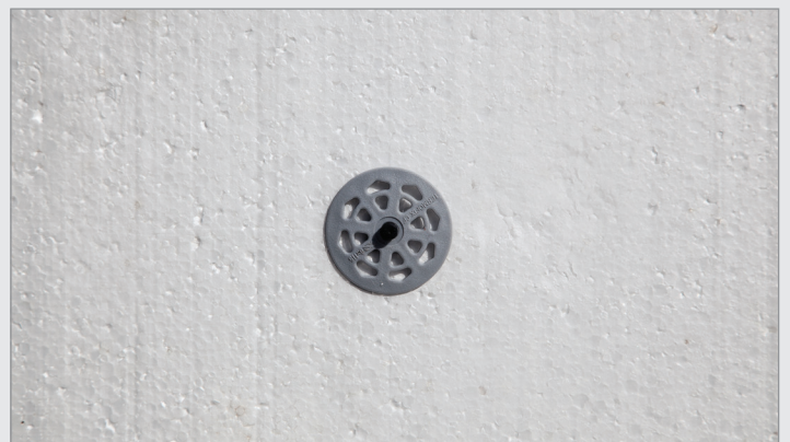
نصب بست‌های Termofix
