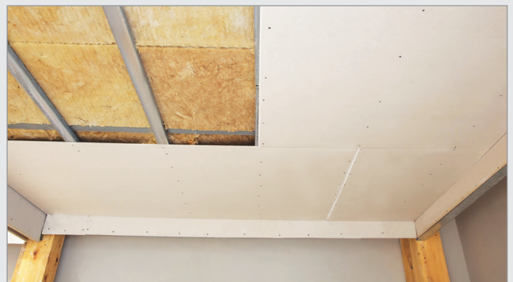
عایق کاری سقف ساختمان
