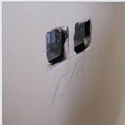
برش نامناسب پنل
