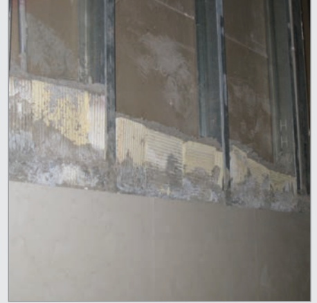
پر کردن فضای خالی دیوار با انواع مصالح صلب
