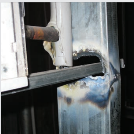
برش سازه با ابزار نامناسب
