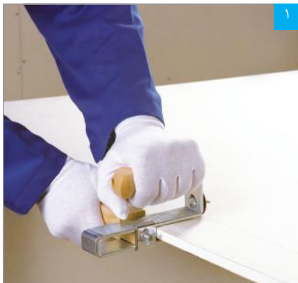
برش پنل با دستگاه برش قرقراهی
