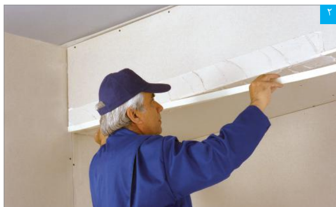
۲ قرار دادن نوار درزگیر بر روی بتونه
