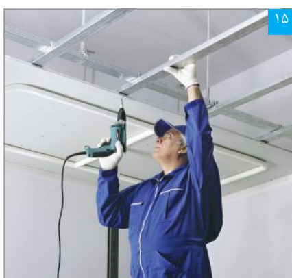
اتصال پنل به زیرسازی توسط پیچ
