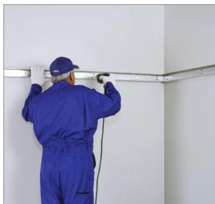
نصب سازه تراز باربر
