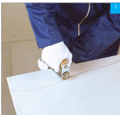
اجرای برش موج‌دار با دستگاه برش قرقراهی
