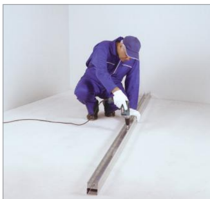
اجرای سازه سقفی دوتایی
