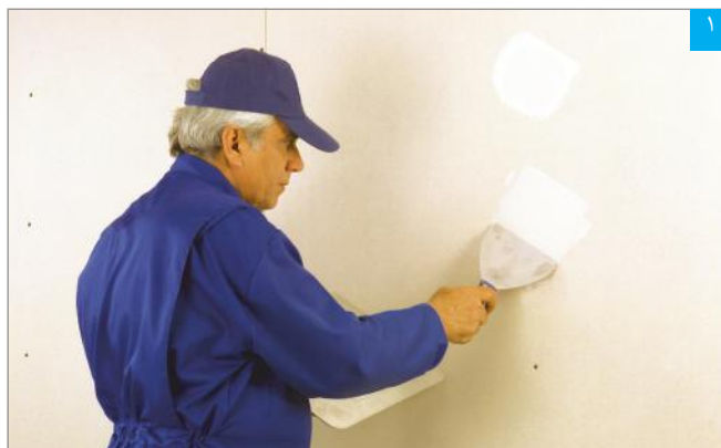
اجرای بتونه در محل پیچ‌ها
