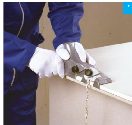
اجرای پخ با پخ زن
