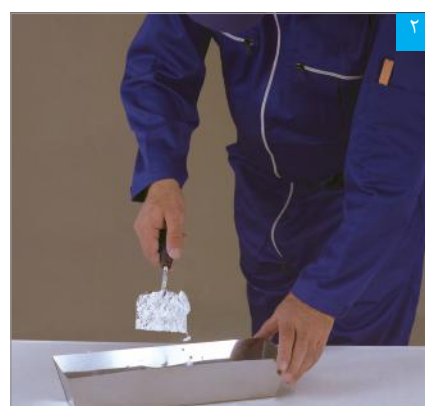
ریختن پودر بتونه در آب
