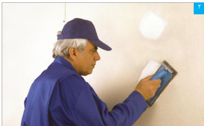
پرداخت سطح بتونه خشک
