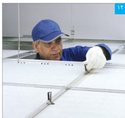
قراردادن گیره‌های مخصوص نگهدارنده تایل
