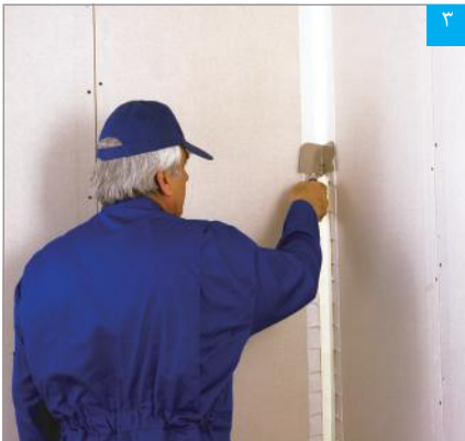
۳ تثبیت و شکل دهی نوار درزگیر با کاردک زاویه خارجی
