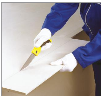
برش پنل با اره دستی
