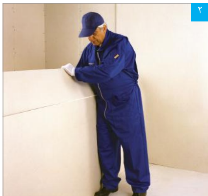
شکستن پنل در محل برش
