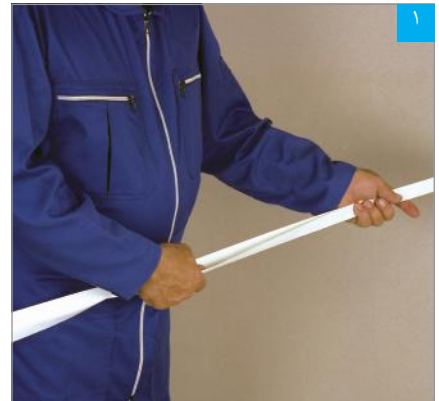
۱ خم کردن نوار درزگیر با دست
