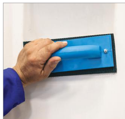
مرطوب کردن سطح دیوار با اسفنج نمدار
