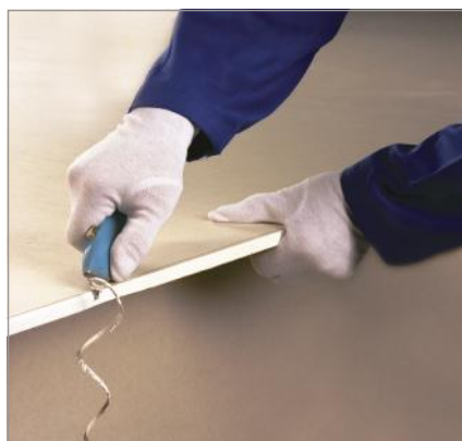
اجرای پخ با تیغ برش
